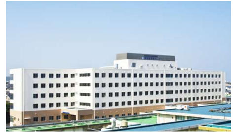
福岡東医療センター （福岡県古賀市・549床）
